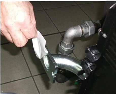
7) Снять заглушку из Труба ГАЗОВОЙ рампы;
