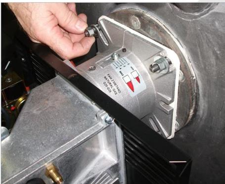
7) Зафиксировать горелки на котел;
