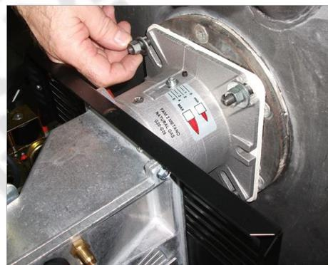
6) Зафиксировать горелки на котел;
